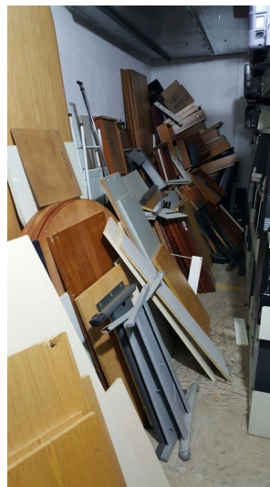
Figura 22: Móveis em contato direto com o piso e com a parede
