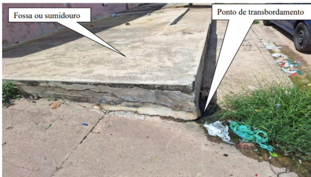
Figura 02: Ponto de transbordamento de fossa/sumidouro para a via pública. Fonte: ASTEC/PRODEMAC 2024.
