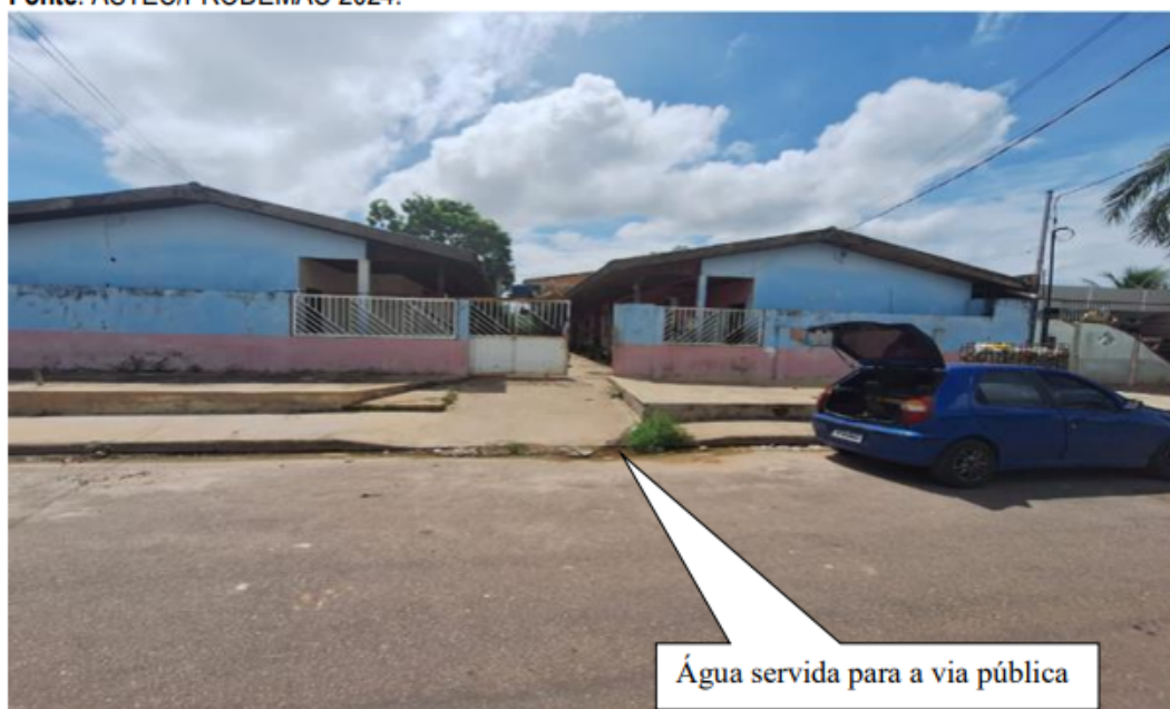
Figura 03: Lançamento de água servida para a via pública. Fonte: ASTEC/PRODEMAC 2024.
