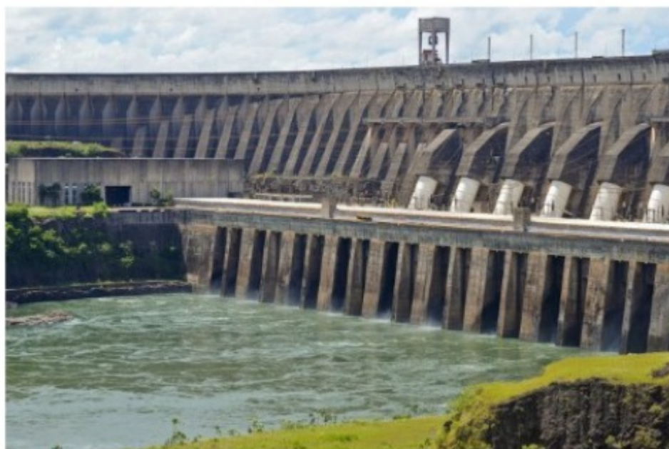
Barragem de Concreto de Itaipu. (Imagem: Flickr)
