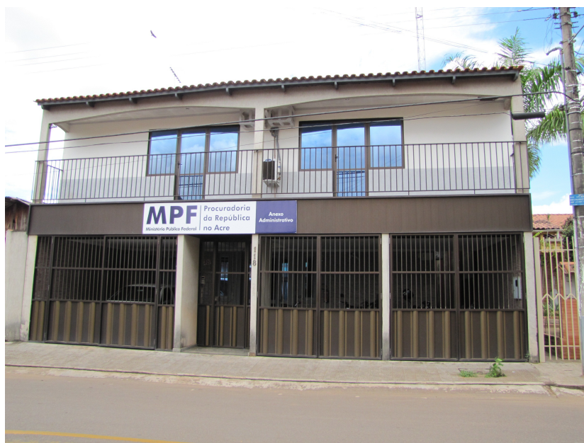
Fachada do Anexo Administrativo
