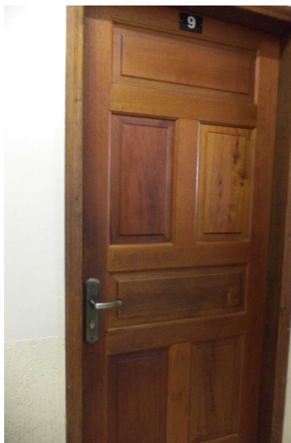
Porta de acesso principal.
