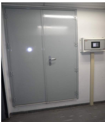
Porta de acesso à sala contígua
