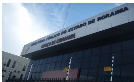
Fachada atual do Edifício do Espaço da Cidadania – MPE.
