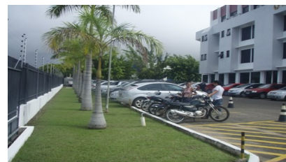
Detalhe do estacionamento interno.
