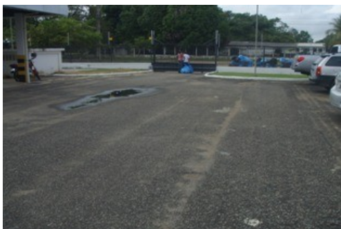
Vista do portão lateral de entrada e saída de veículos.
