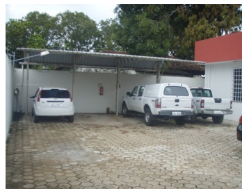
PTM BOA VISTA: GARAGENS COBERTAS
