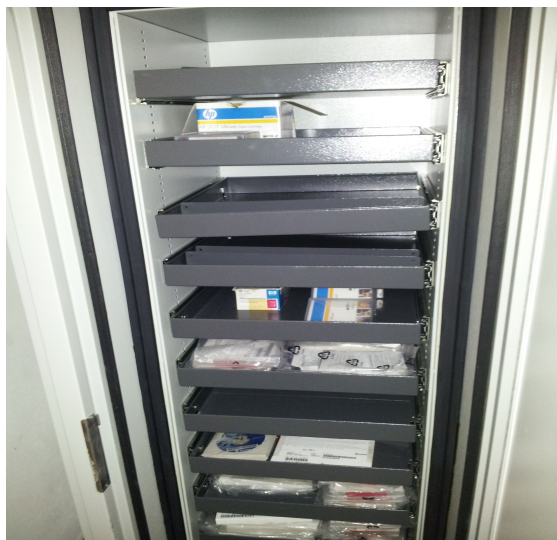
Foto 1 – Cofre antichamas para armazenamento das fitas de backup.
