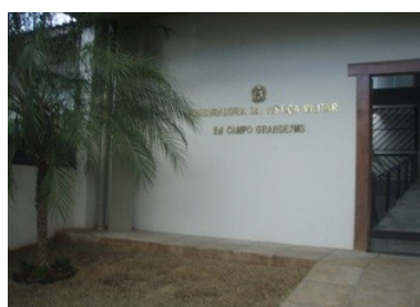
Detalhe da fachada.
