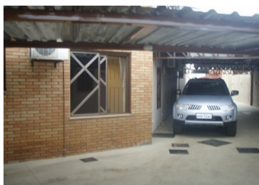
Vista externa de grade de proteção de janela, no padrão adotado pela PRT.
