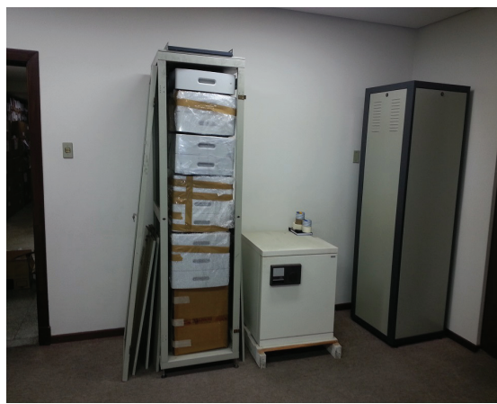
Ilustração 4: Cofre para guarda das fitas de backup
