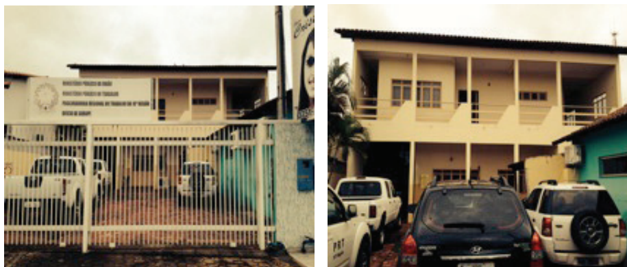
Fotos da fachada da PTM-Gurupi, com identificação da unidade e garagem descoberta.
