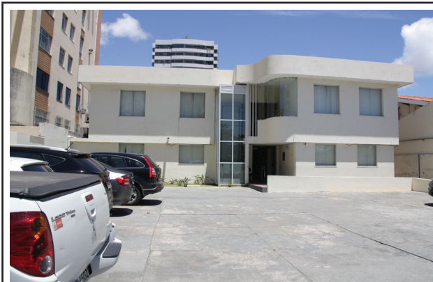
Ilustração 7: Fachada do Anexo II
