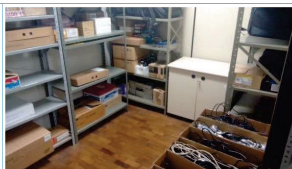
Depósito dentro da sala do CPD
