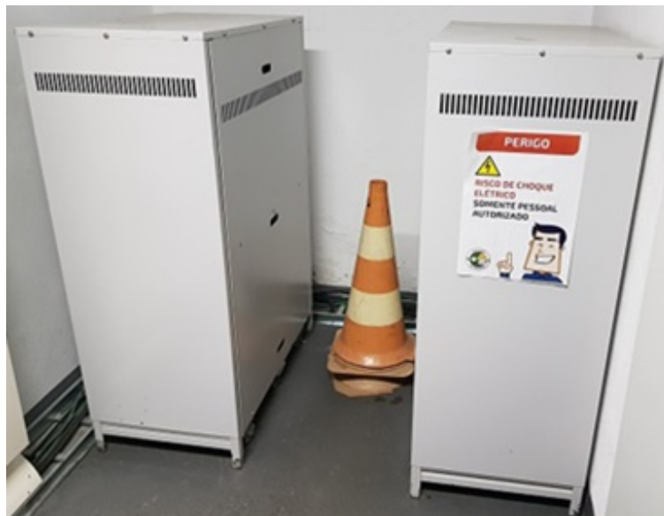
Foto 2: Visualização dos dois bancos de baterias do No-break .
