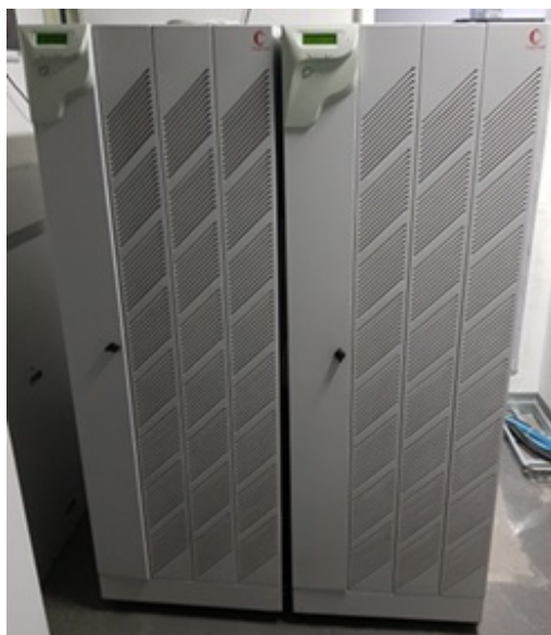
Foto 1: Módulos principais de No-breaks Engetron modelo DWTT50A-380.
