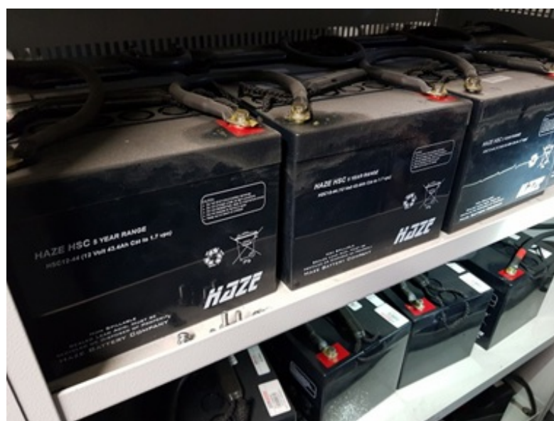
Foto 4: Detalhe das baterias que integram um dos bancos de baterias
