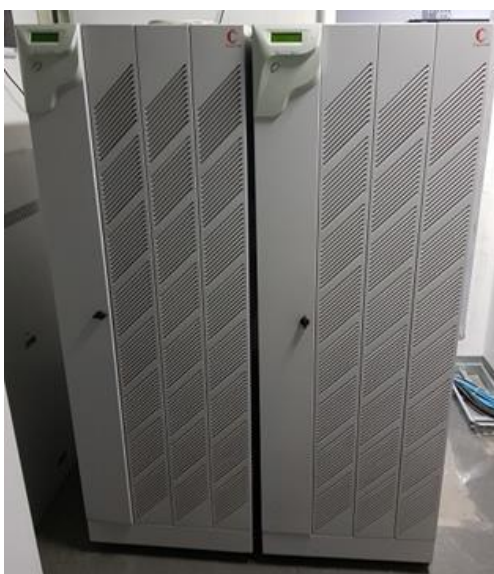
Foto 01: Módulos principais de No-breaks Engetron modelo DWTT50A-380.
