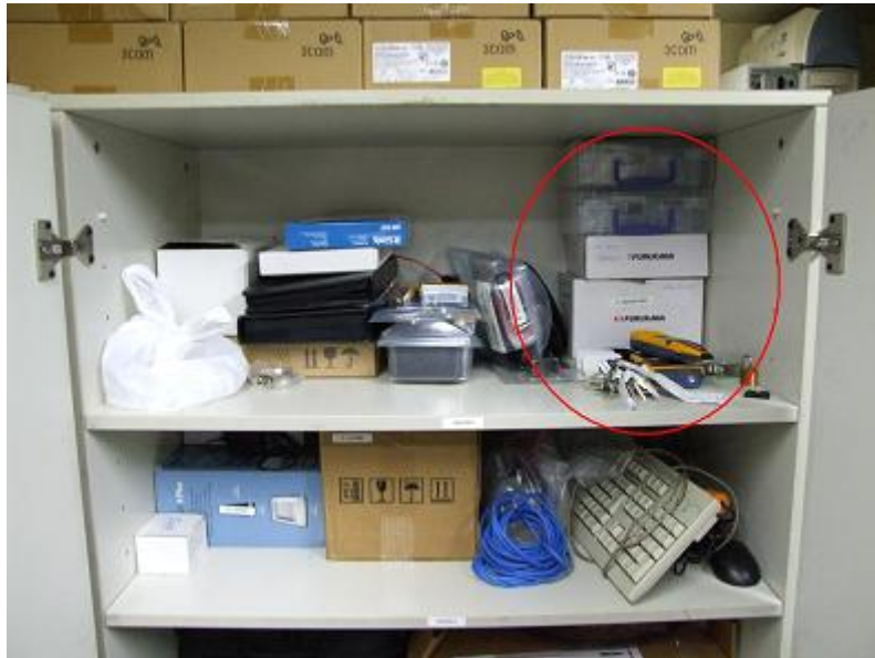
Figura 2 - armário das fitas de backup
