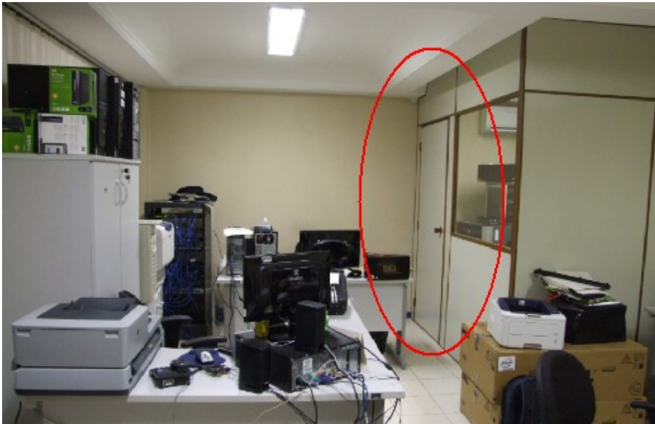
figura 6 – sala do datacenter
