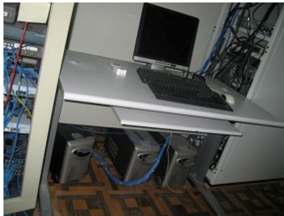
Fotografia 07 – Sala destinada ao CPD
