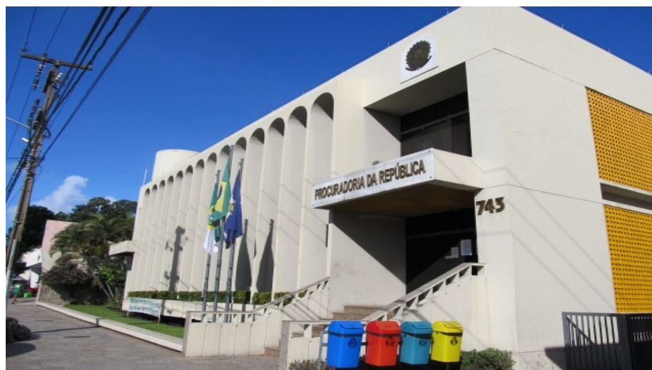
Figura 1. Fachada do Prédio da PR/RN. Em primeiro plano a escada de acesso, sem rampa.
