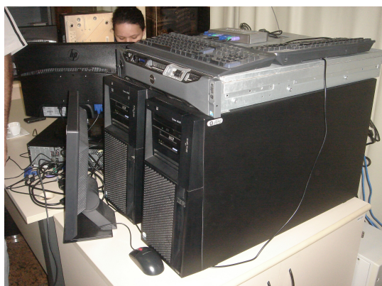
Servidores armazenados em cima da mesa de funcionário.
